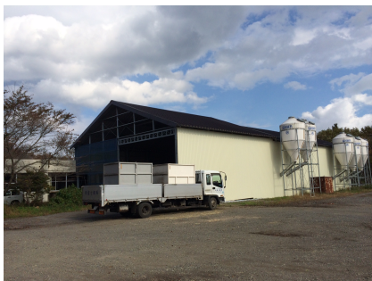
蔵王アップル、雪対策で壁を張りました！
